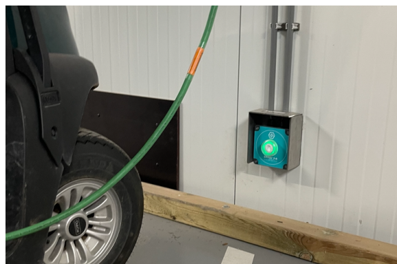
Een MPS-sensor in een beschermend roestvrijtalen bakje
